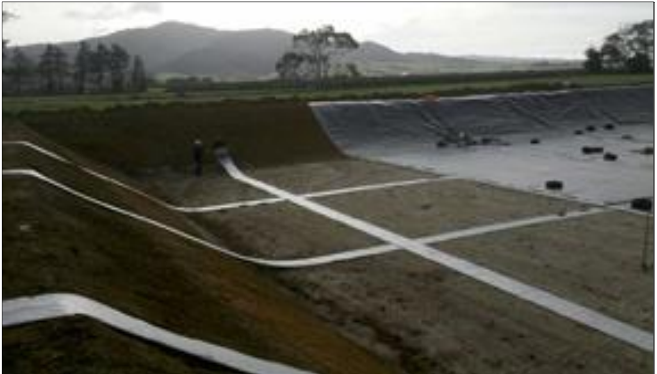
Dairy Effluent Pond : Sub-Grade / Liner Gas Vent
